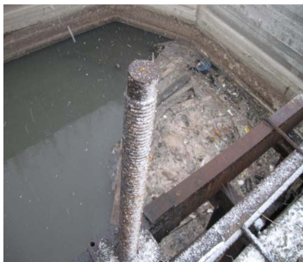
Рис. 4. Городская насосная станция (ГНС).
