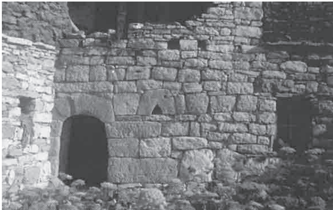
Рис. 1. Сохранившаяся стена дома
